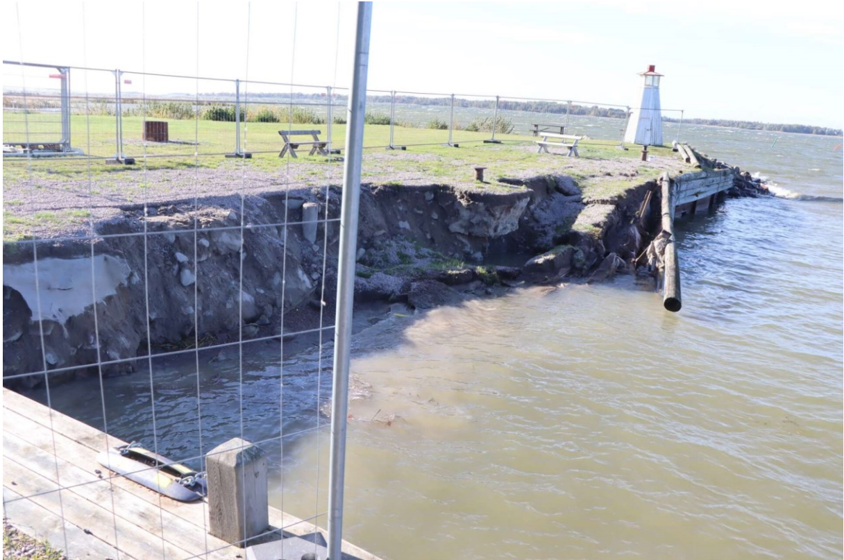
Bild från efter att kajen hade rasat samman. Foto: Per Claesson
